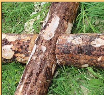
Детали каркаса соединены крестовидно вполдерева
