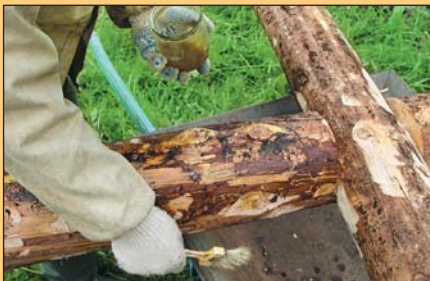
Перед установкой крестовины желательно обработать защитной пропиткой
