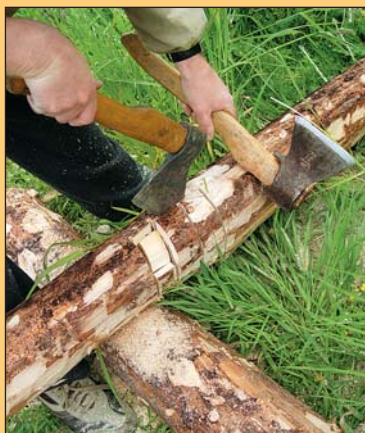
Древесину между пропилами удобно удалять двумя топорами
